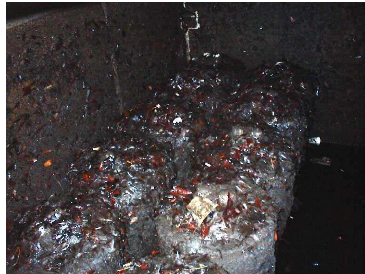
(d) StormScreen vault, January 17, 2004
