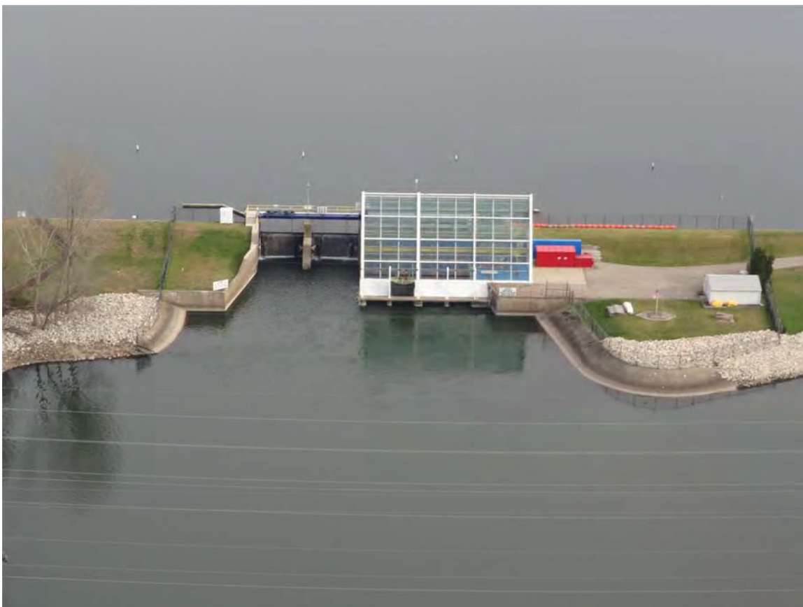
24. Morrow Lake Dam.
