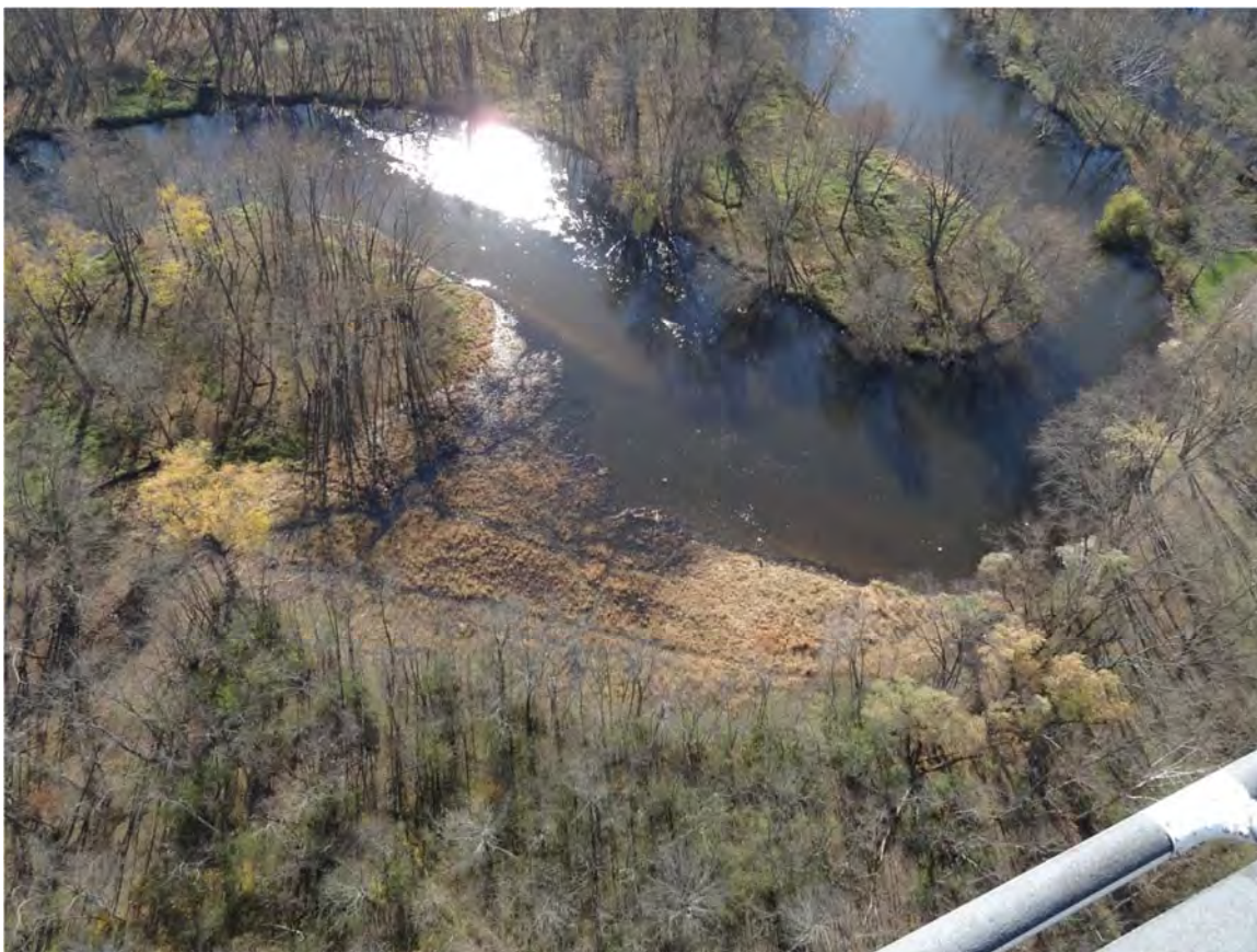
27. MP26.0 RDB Sediment Trap.
