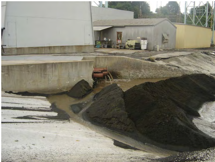
24. Slag Settling Pond Inlet
